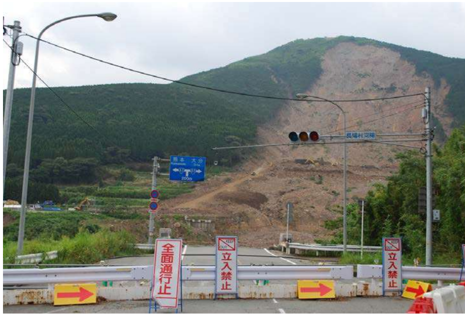
阿蘇大橋の崩落現場
