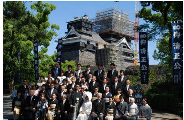
天守閣再建に向けて一部解体工事が始められた頃 (平成29年5月)
