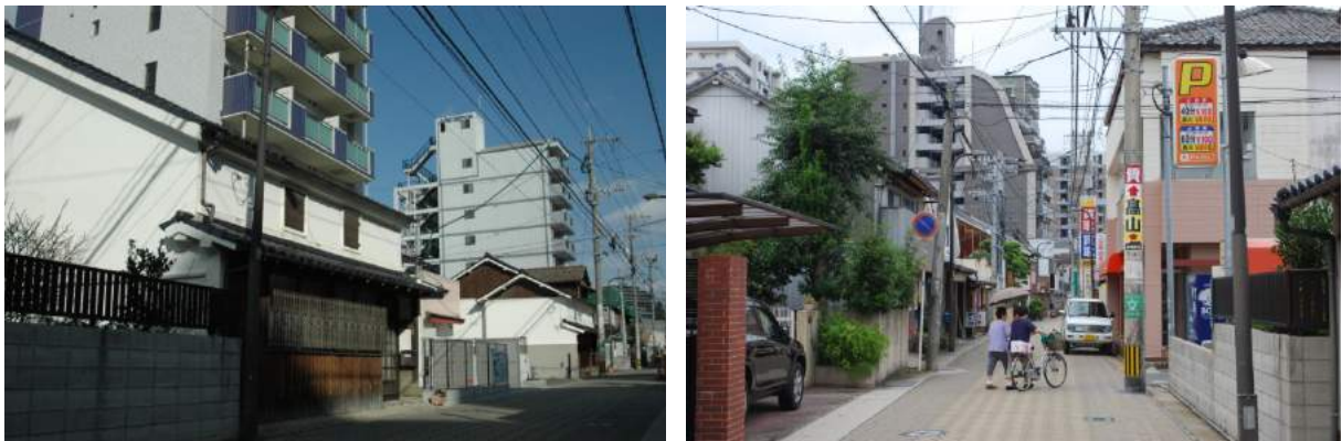
景観形成への配慮が望まれる高層マンション
