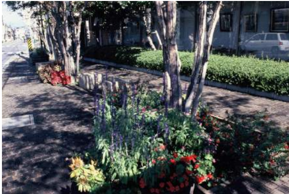
栗の木のブロックが敷き詰められた歩道
