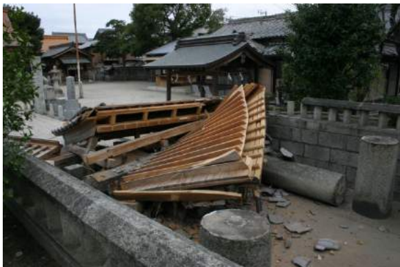
福岡県西方沖地震での姪浜住吉神社の被害
