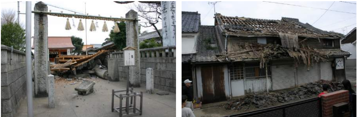
福岡県西方沖地震による姪浜での被害例：姪浜住吉神社(左)、伝統的町家建築(右)
