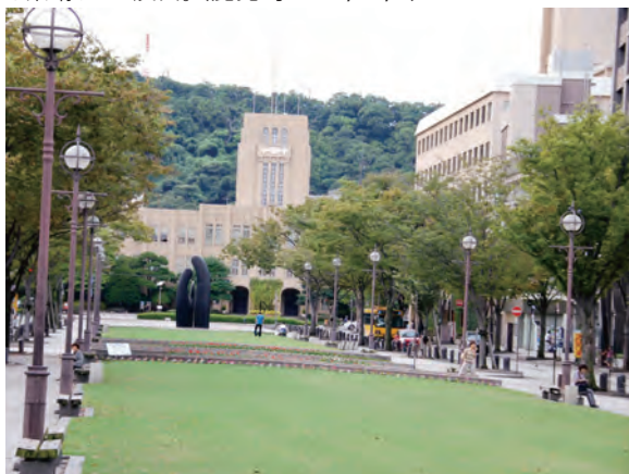
写真 91: 中央分離帯に芝生広場を設けている。芝生も良く手入れされており、心地よい緑空間を形成。(鹿児島 2009/9/12)
