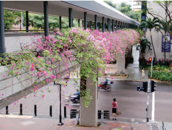
写真 124:歩道橋の側壁から下垂するブーゲンビリア。車道から効果を高めている。(シンガポール 2009/3/19)
