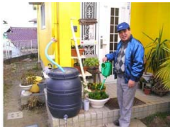
写真21 雨水貯留用リュースタンク
