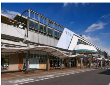
写真 10…地下鉄姪浜駅
