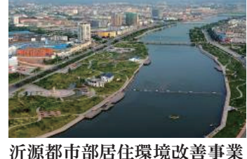
沂源都市部居住環境改善事業 (中国 山東) Shandong, China
