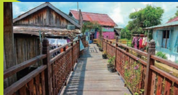
アララック・セラタン地区改造事業 （インドネシア バンジャルマシン） Banjarmasin, Indonesia
