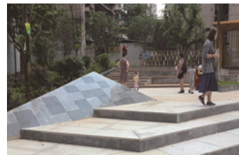
貴陽市南明区バラック地区改 造プロジェクト (中国 貴陽) Guiyang, China
