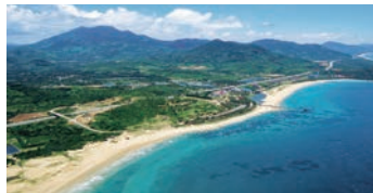
万寧市海岸線保護プロジェクト (中国 万寧) Wanning, China
