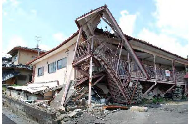
熊本地震の脅威の実感 — 左:阿蘇大橋の崩落(南阿蘇村)、右:2階建てのアパートの倒壊(益城町)
