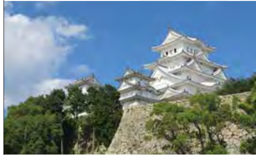
保存修理を通じて次世代に継承する人類の文化遺産姫路城とまちづくり (日本 姫路) Himeji
