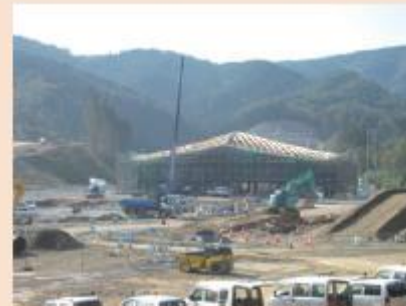
女川駅周辺工事
