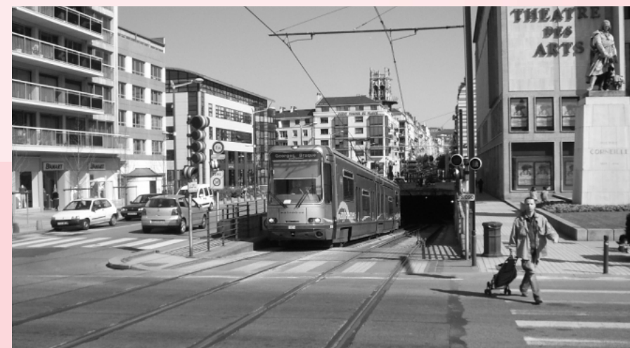
写真8-2: 地下区間から地上区間への移行部分。車道の左側に見える道路がメインストリート。(ルーアン)
