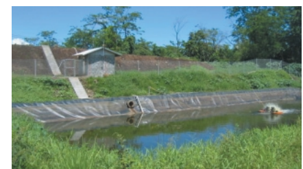
完成した污水处理施設
