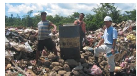
サモアの埋立場のガス抜き管の施工
