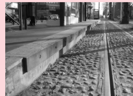
写真6-1: ホームの側面に木材の板が貼り付けてあるのが分かる。(リール)
