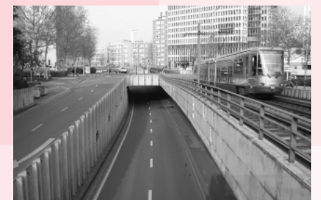
写真9: 道路が半地下となっている。空間の有効活用例。(ルーアン)
