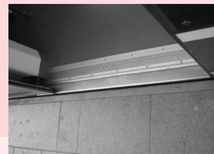
写真6-2: 車両(写真上半分)とホーム(写真下半分)の隙間を木材が見事に埋める。(リール)
