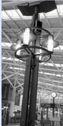
写真10：台湾高鉄 左営駅の照明街灯のよう
