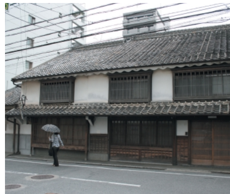
■高取商店街の通り沿いにある明治時代に建てられた町家
