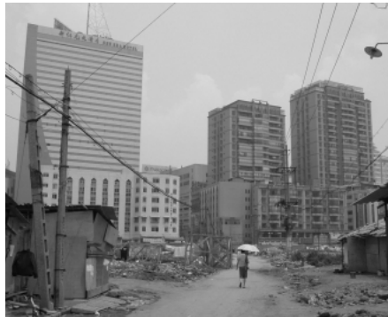
「牛街」再開発工事現場
