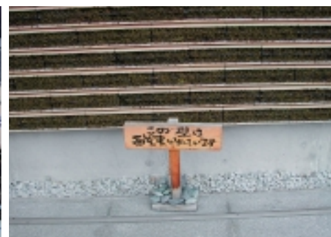
■苔が一面に貼られた、呼吸をしている壁(博多区博多駅前)
