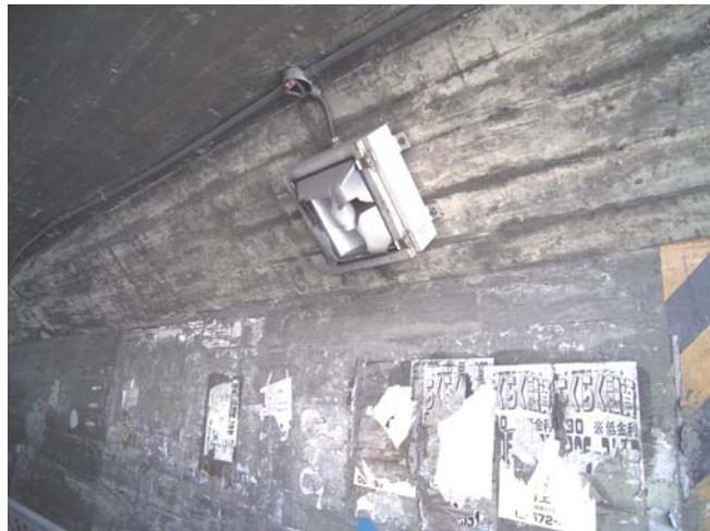
図19 貼紙を剥がした跡と破損した照明
