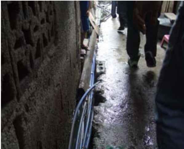
Kababan 地区給水の様子
