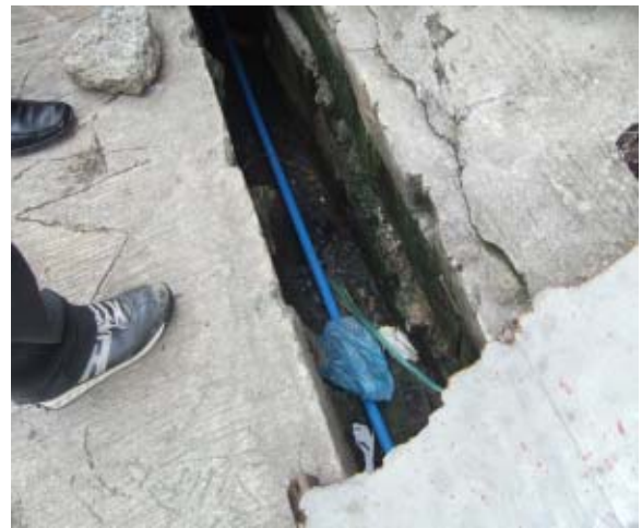
水道管の様子
