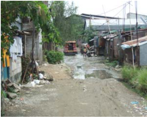
バランガイ Pangholo 地区の様子 道路は舗装されておらず、窪みに水溜りができている。水道管は道路の下に埋設されている。
