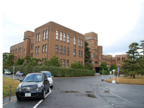
写真 7-14 旧工学部本館
