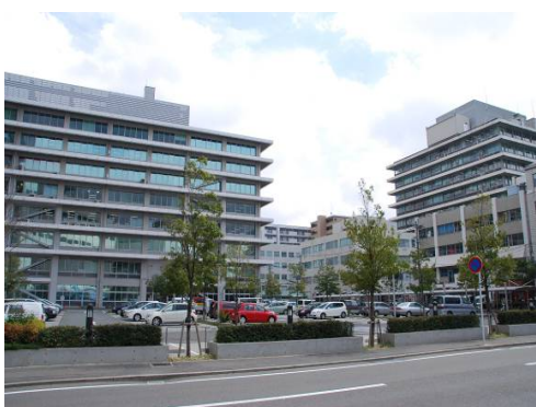
写真 7-8 福岡合同庁舎
