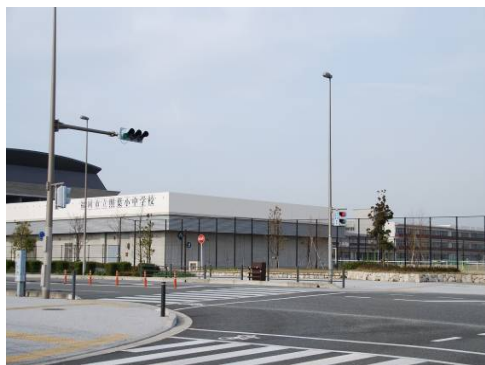
写真 7-7 福岡市立照葉小中学校
