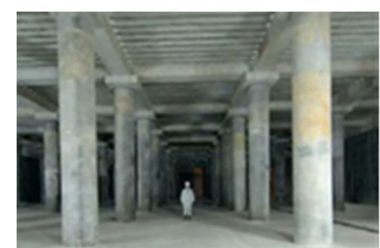
Hồ điều tiết nước mưa Sanno số 2
