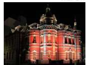
写真提供: 福岡市
