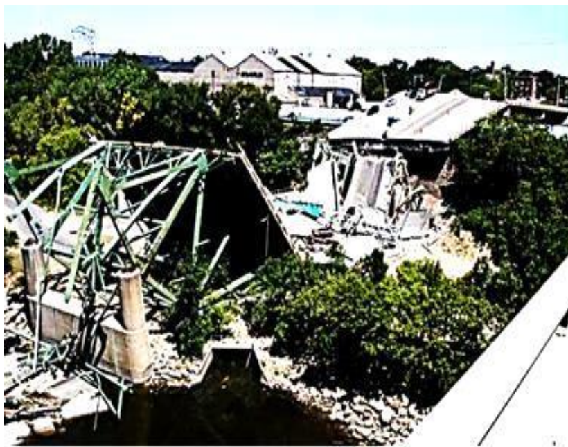
崩落後の状態
