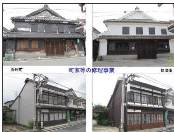
町家等の修理事業例
