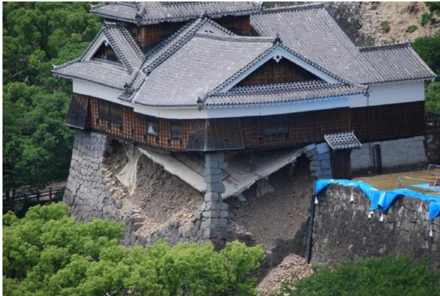
熊本地震で大きな被害を受けた熊本城
