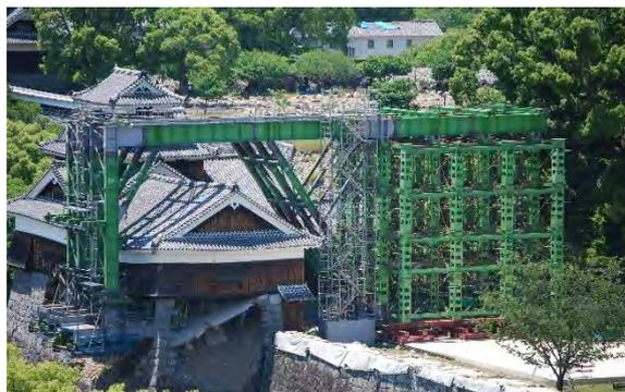
熊本市 熊本城 天守閣再建に向けて一部解体工事が始まった頃(左)。「奇跡の一本石垣」で知られる飯田丸五階櫓も櫓倒壊防止のための崩落石材回収工事が進められていた(右)。(2017年5月)
