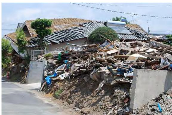
南阿蘇村 東海大学周辺の学生村の被害状況。2階建てのアパートの1階が押し潰されている。(2016年8月)
