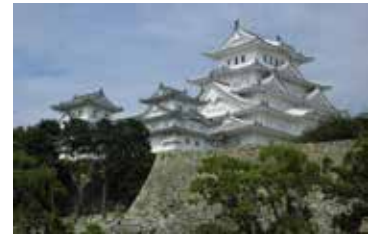
保存修理を通じて次世代に継承 する人類の文化遺産姫路城とま ちづくり (日本 姫路) Himeji
