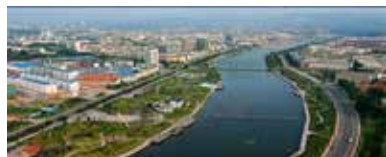
沂源都市部居住環境改善事業 (中国 山東) Shandong
