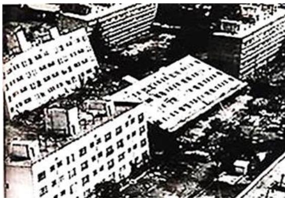
写真1 新潟地震で、地盤の液状化により倒壊し
