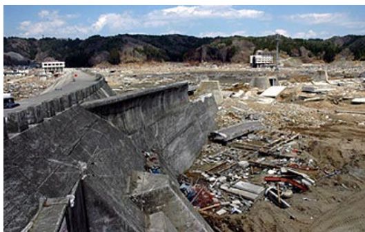
写真 6.5 震災後の田老の防潮堤 出所 岩手日報 webnews「再興への道」
