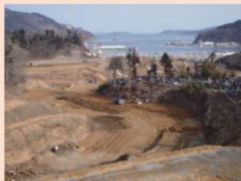
中心部盛土工事
