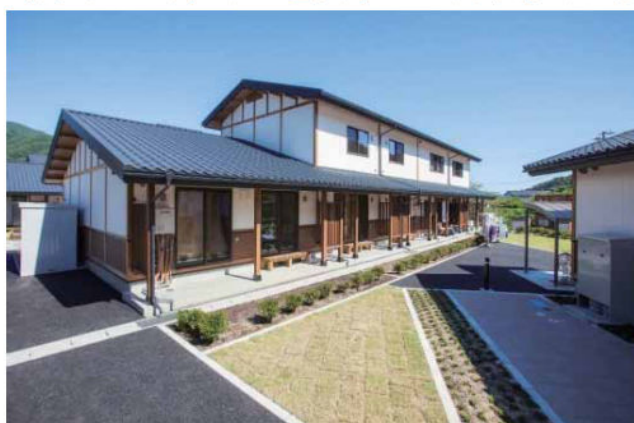
写真 6.6 大槌町災害公営住宅 大ケロ地区
