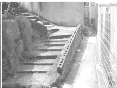
階段は家屋玄関へ、右が通り抜け道（西新）
