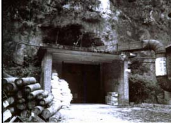
トンネル中の工場
